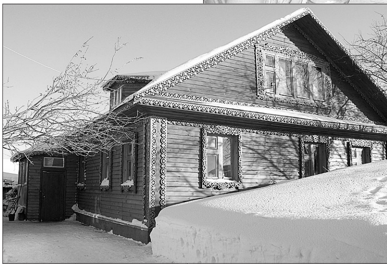
Всю зиму работал хозяин над деревянными кружевами дома.
